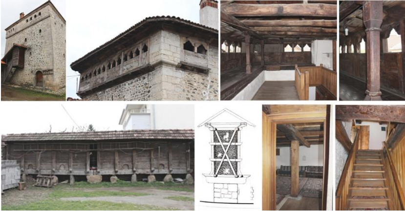
Figura 13. Elemente nga druri në Kulla dhe hambarët brenda kompleksit; vizatimi poshtë (Doli, 2001)
